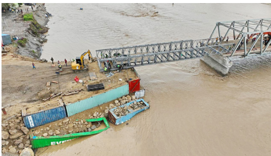
Pengerjaan jembatan bailey pada Jembatan Teupin Mane, Kecamatan Juli, Kabupaten Bireuen, Aceh sudah hampir rampung, pada Sabtu (13/12/2025). Foto: BNPB.
