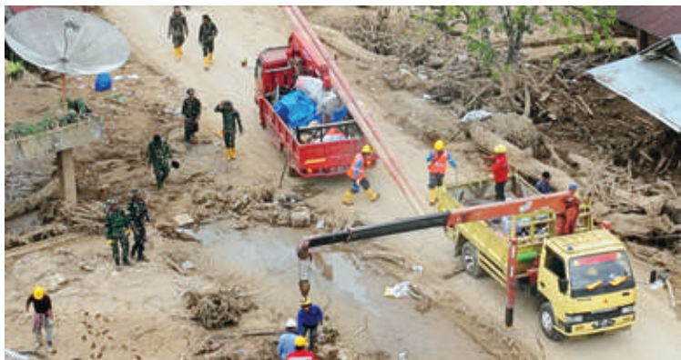
Petugas melakukan perbaikan pada infrastruktur jaringan listrik yang terdampak banjir bandang di Kabupaten Agam, Provinsi Sumatra Barat. Sejumlah personel TNI turut membantu dalam penanganannya. Sumber foto : BNPB
