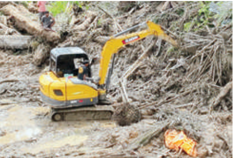
▲ Alat berat berfungsi untuk mempercepat penanganan darurat bencana. Pembersihan material yang terbawa arus banjir berjalan dengan efektif pascabencana banjir dan tanah longsor yang menerjang tiga provinsi di Sumatra. Sumber foto : BNPB
